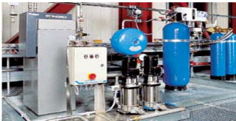
Großanlage Kesselwassernachspeisung
